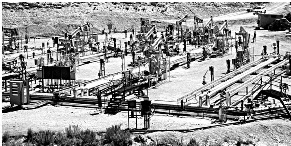
Рис. 5. Установа Shell для видобування сланцевої нафти in situ (на місці залягання)
